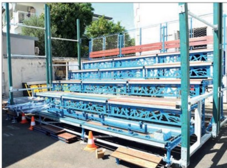
Chaque container du dispositif Mobiltéat dispose d'une scène de 26 m 2 et d'un gradin amovible de 50 places.
